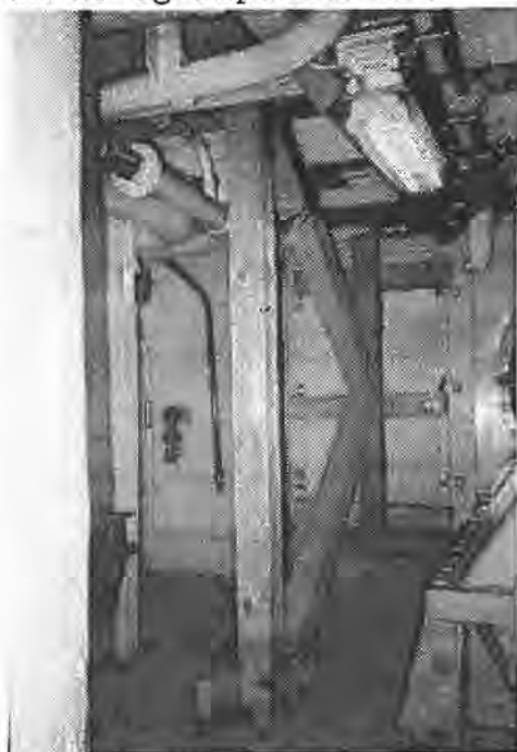
En perfekt V-afstivning i MØEN under en havariøvelse under øvelse PLAYEX I. (MØEN FOT).
