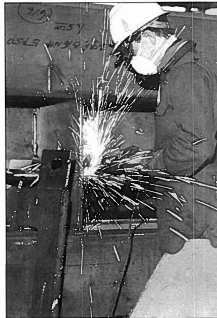
Fra store stålkonstruktioner, der kræver transport ad søvejen, til serieproduktion af mindre konstruktioner.
