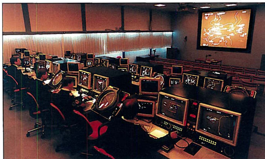
Kontrolrummet, hvorfra det hele styres
