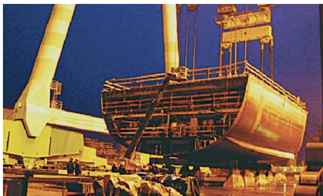
Køllægning, portal-kranen tager fat
