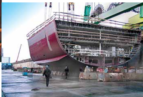
Køllægning, første blok netop placeret på køllodserne
