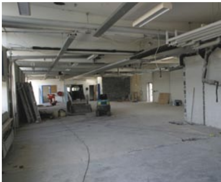
Den tidligere Sømine/Rigger/Havnekontorbygning under ombygning til Værksted Danmark.
