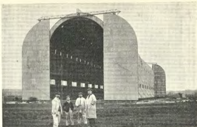
Fig. 5. Cléments Luftskeibshavn i Lamotte-Breuil til 2 Luftskeibe à 7000 m 3 .
