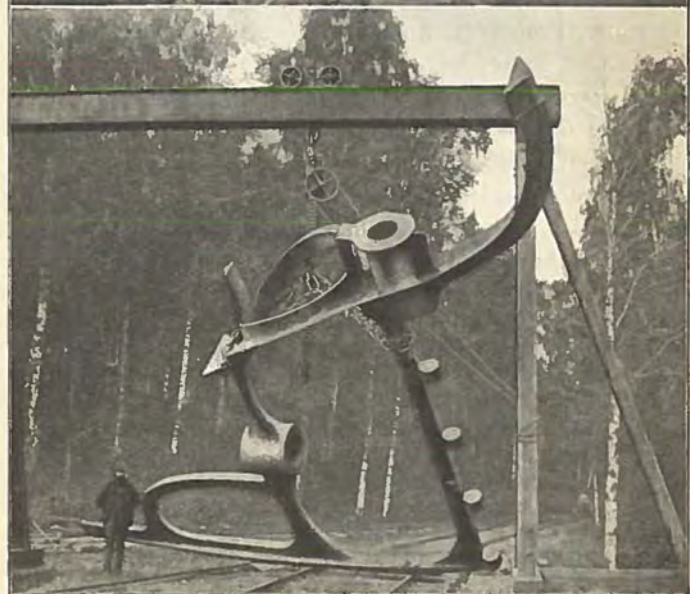
Fig. 1. Stevn og Rorstamme af Støbestaal.
