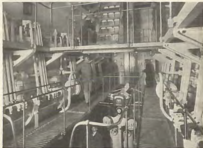
Maskinrummet over Manøvrepladsen.
