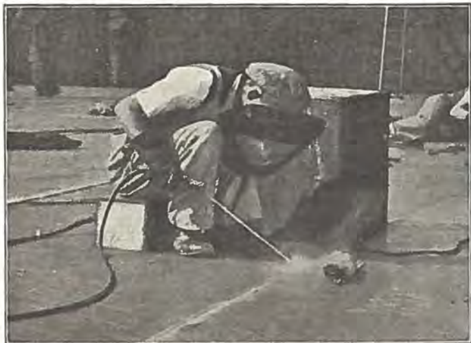
(Fig. 8). Svejser med Beskyttelsesskærm og -handsker ved Arbejdet ombord.
