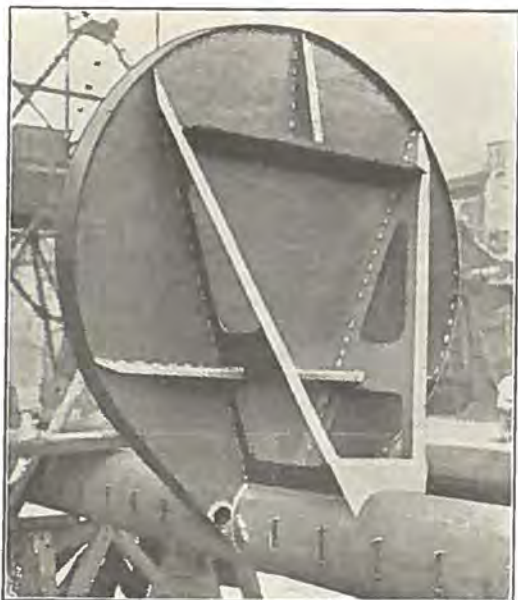
(Fig. 21). Svejst Mast med Platform.
