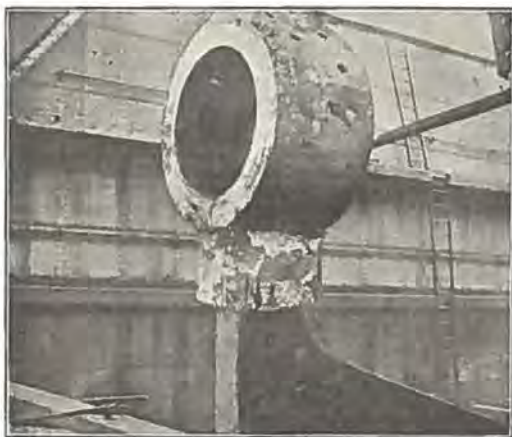
(Fig. 1). Udført Reparation ved Termitsvejsning paa en Agterstævn.
