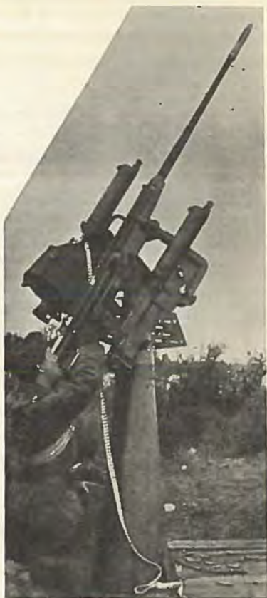
Fig. 2. 20 mm Maskinkanon (Hispano-Suiza) + 2 Stk. 8 mm Maskingeværer i samme 2-aksiale Affutage.
