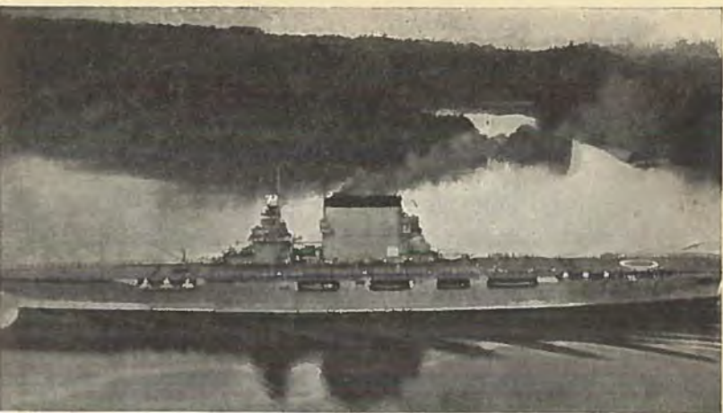
Amerikansk Aërodromskib LEXINGTON i Gatun-Søen (Panamakanalen). Den hvide Cirkel paa Flyvedækket agter tjener til Vejledning for Luftfartøjerne under Landing
