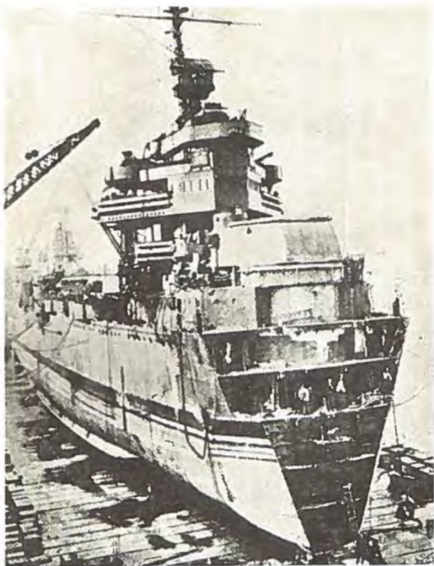
Fig. 2. »New Orleans« i Dok i Puget Sound. Det provisoriske Forskib er fjernet, og alt er klar til at modtage det nye.
