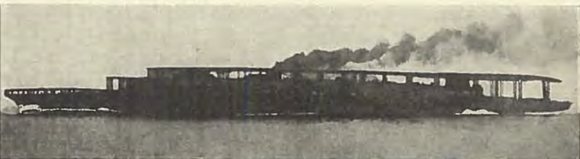
Japansk Aërodromskib AKAGI for Ombygning. Ved Stalkonstruktioner var Flyvedækket hævet op over Hangartaget. Foruden Flyvedækket anvendtes tillige Bakdækket — og muligvis ogsaa Mellemdækket — til Start
