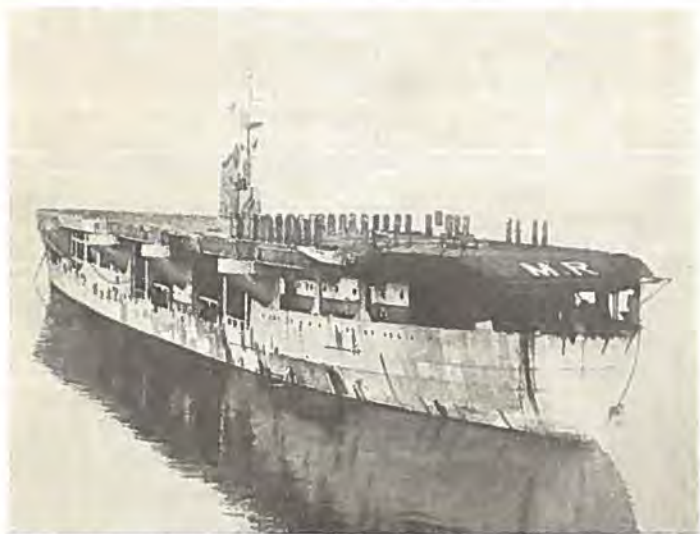
Hollandsk Koffardi-Hangarskib MACOMA (ombygget Tankskib). Foran for og paa Siderne af Elevatoren kan der — som vist paa Billedet — rejses »Palisader« som Vindskærme for at give Læ til Luftfartøjerne, naar de fra Hangaren kommer op paa Flyvedækket.
