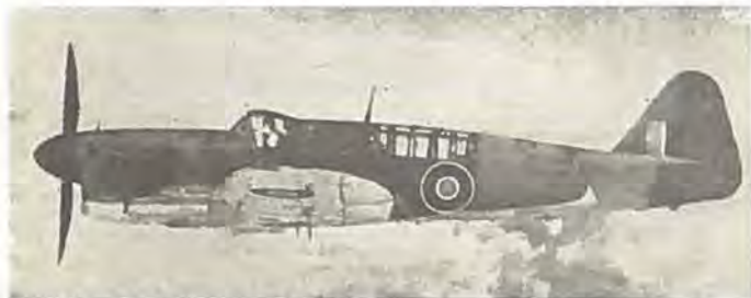
Fig. 5. Firefly. To-Sædet. Jager-Rekognoscering. Armering 4 Stk. 20 mm. Hangarskibsbaseret. Engelsk Type.
