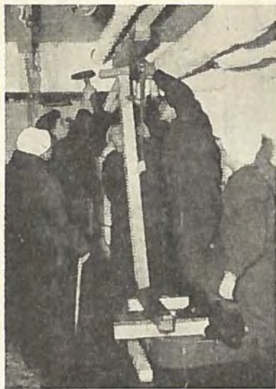
Fig. 6. Fra et øvelsesrum i »U.S.S. Buttercup«: afstivning af en vand-tæt lem.
