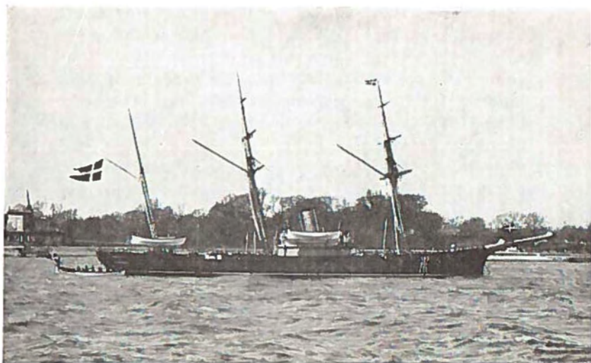
Krydseren DIANA på Københavns Red. 1894. Opbygningen med kommandobroen forlænget til foran for skorstenen.
