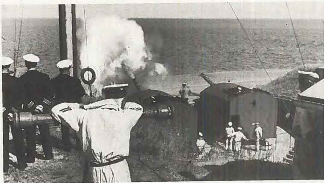
Middelgrunden, 17 cm batteri (Foto: Orlogsmuseet) Ved forsvarsordningen af 1932 overførtes Kystdefensionen fra hæren til søværnet uden tilstrækkelige midler til modernisering af de forældede og nedslidte anlæg.
