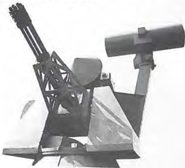
GOALKEEPER med søgeradar, målfølgeradar og kanon.
