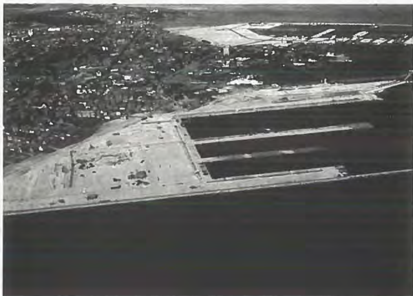
Etablering af Flådestation Frederikshavn (1958).
