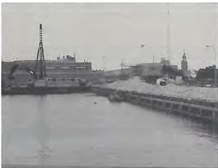
Ombygning af kajanlæg på Flådestation Korsør.
