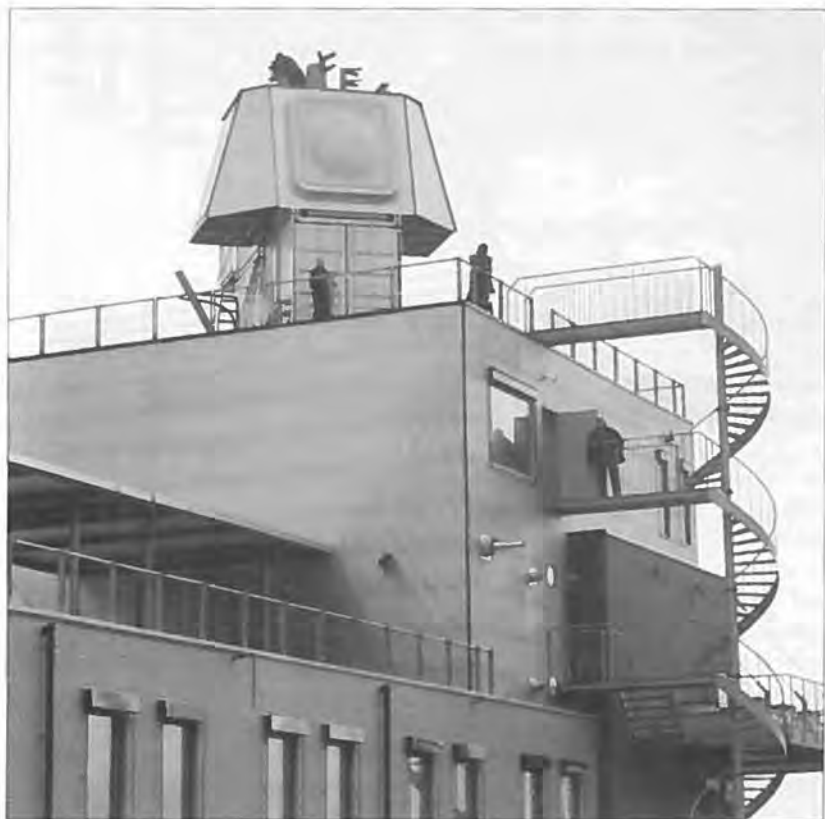
APAR plade i mastemodul under test i Holland (Gengivet med tilladelse fra SIGNAAL)
