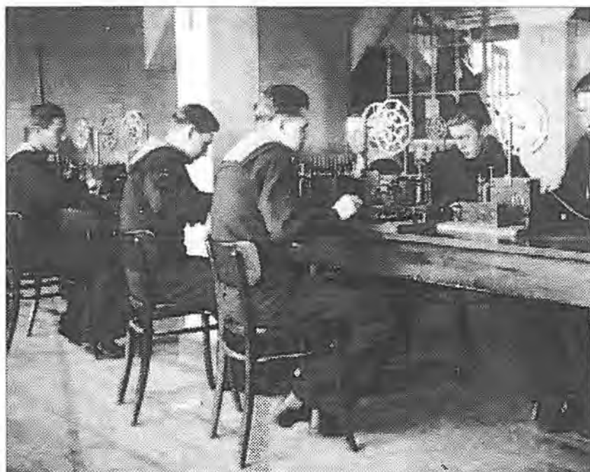
Fig. 2 Fra den store morsesal i stueetagen på bygning 24. Eleverne træner sendeteknik og kan se deres egne morsetegn på den papirstrimmel, der sidder på spolen, som er placeret øverst på apparatet.
