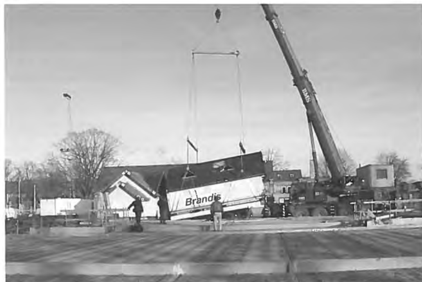
Rasdiostationen manøvreres på plads (december 2001).
