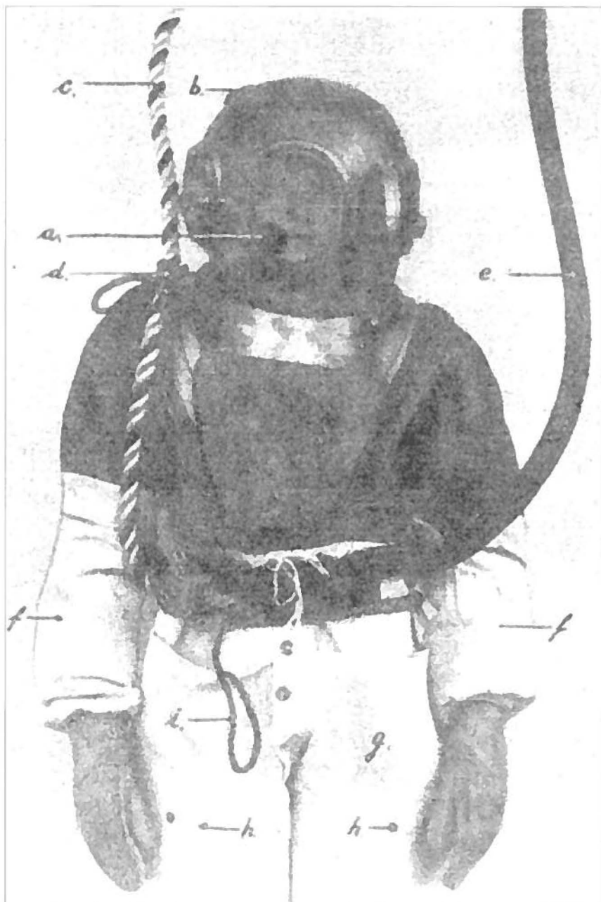
Fig. 5. Konventionel tungdykker søværnets 2-bolts-hjelm. Udfaset.
