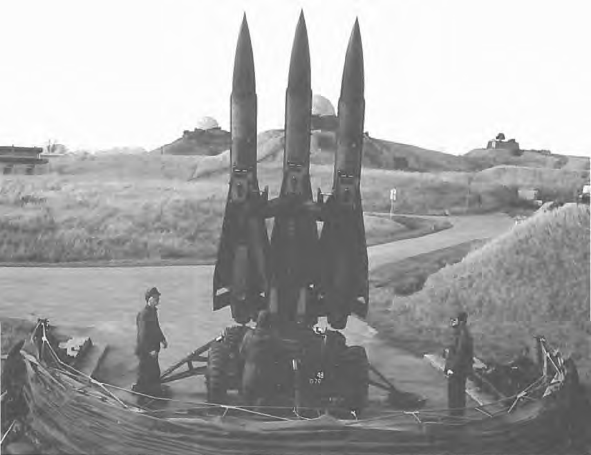
Forsvarets Bygningstjeneste er i færd med at bygge stillingsområder til to af flyvevåbnets IHAWK-eskadriller på Højstrup Øvelsesplads ved Odense. Foto: Flyvevåbnet
