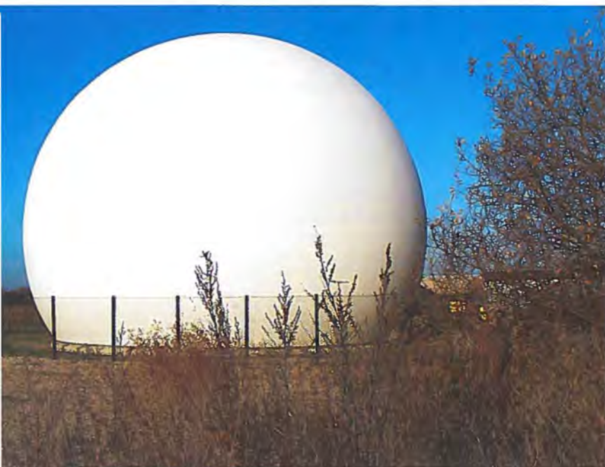
Radome der indeholder en af de antenner, der bruges til indhentning af informationer. (Foto: Forsvarets Efterretningstjeneste)
