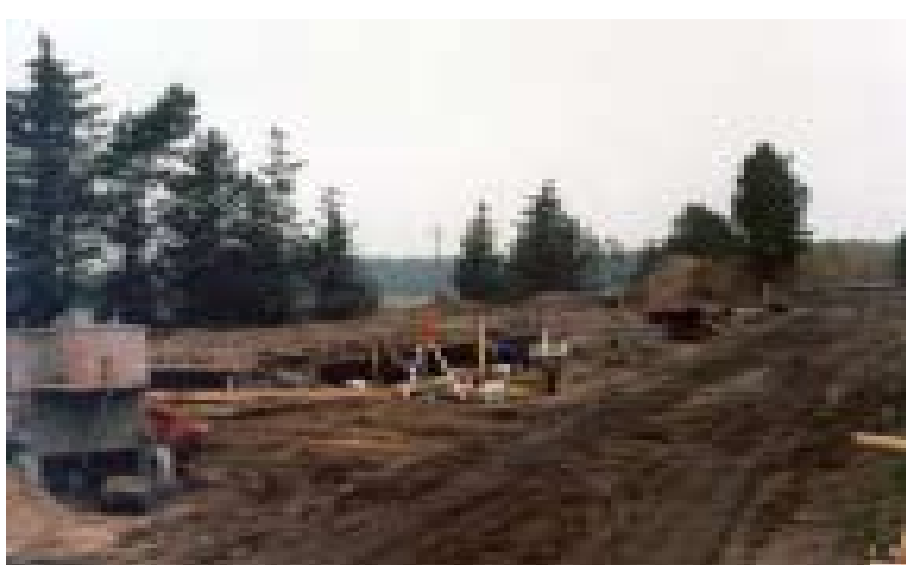
Så er de første spadestik overstået og byggeriet er igang.
