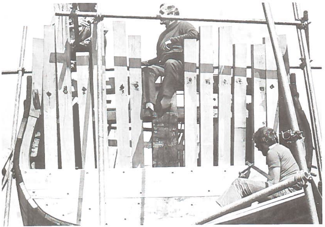
Sommeren 1971. Nyt kraftigt tømmer sikrer nu agterspejlet, der var repareret flere gange – senest i 1948 efter påsejling ved Hals Barre.
