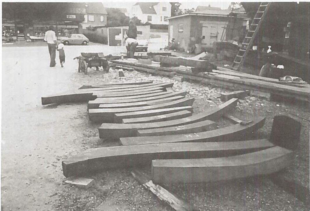
De nye spant-stykker er ved at være klar. 1976. (Foto: Bo Sørensen).
