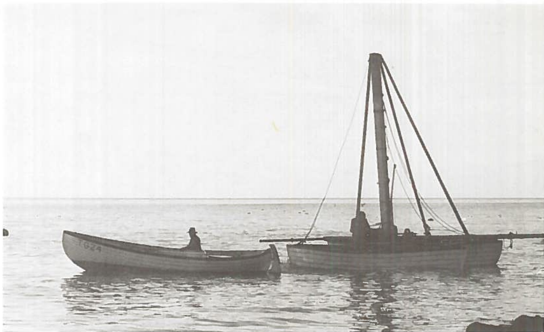
7. 19-fots motorsnipa och pålpräm från Lilla Beddinge på sydkusten, tillhöriga bröderna Nilssons ålfiske. Snipan byggd av Malte Göransson i Oster Jär utanför Trelleborg år 1958. Pålprämen byggd på platsen av fiskelaget själva.
