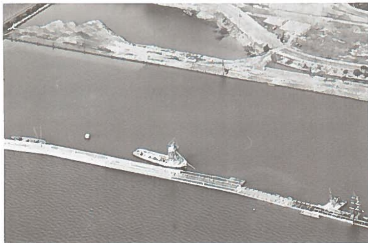
Hvalfisker som betonblanderstation under bygningen af Fredericia vesthavn 1937-39. (Foto: Aero Express).
