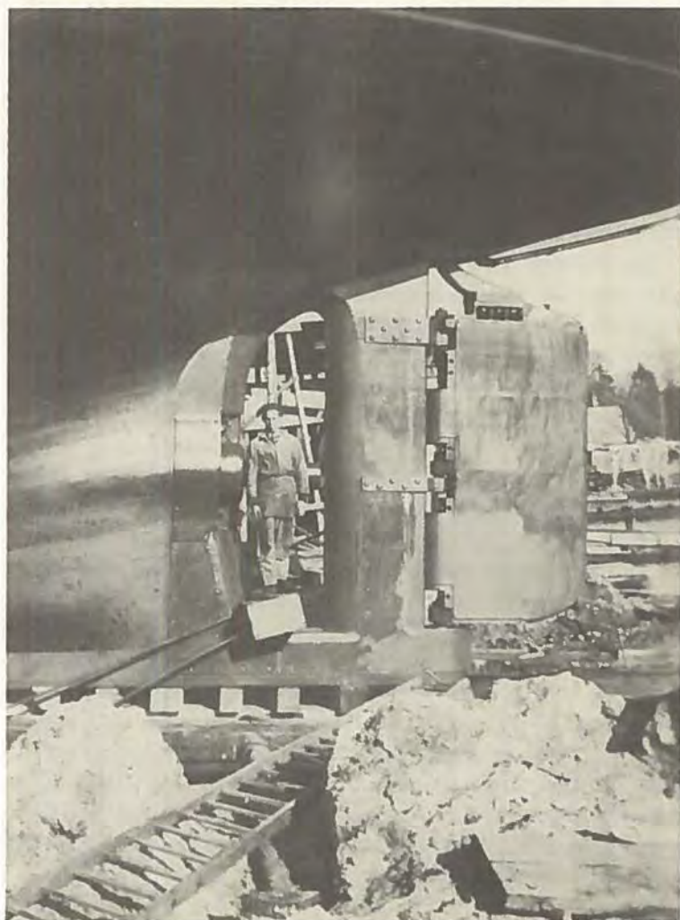
Størrelsesforhold. En middelbøj skibstømmer på en klods på kolen ved rorstammen på G. C. Amdrup under bygning på Frederikssund Træskibsværft 1947.
