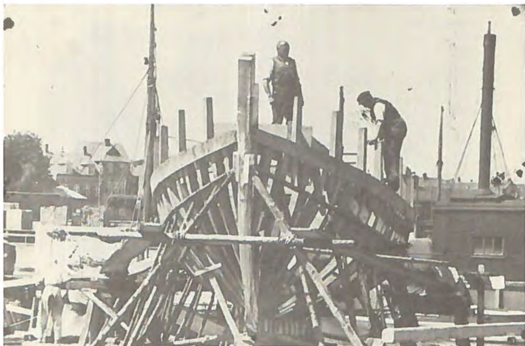
Kerteminde bedding ca. 1943. Nybygning set forfra. Tømrer Niels Knudsen nederst til venstre, mester Viktor Hansen ved stævnen og skibstømrer Laurits Bagge ved støtterne.
