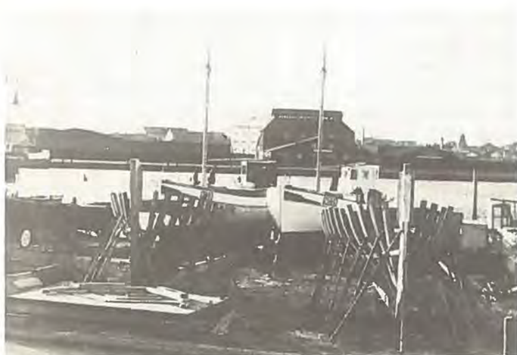
Kerteminde Skibs- og Både-byggeri 1935. NG 9, N. C. Nielsen, bygget til Kerteminde-fiskeren Mathias Nielsen; NG 39, Ulla Mohr bygget til Kerteminde-fiskeren Vilhelm Mohr; og to påbegyndte nybygninger, den ene af dem ved planen til opkræpning og samling af spanter.
