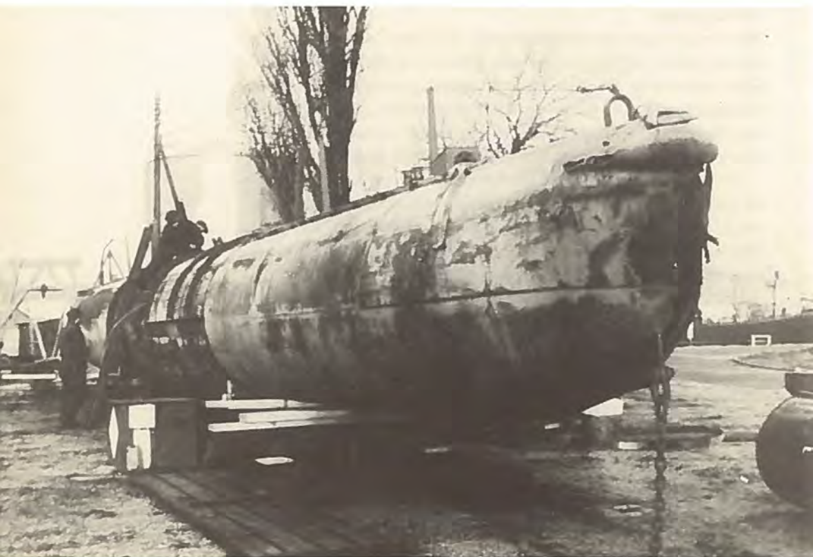
Den 24 meter lange flydemagnet, som vejede ca. 40 tons er løftet på land på Holmen for et eftersyn. På midten ses den beskyttende træbeklædning med bandagerne. Øverst ved stævnen skimtes den store stikkontakt, hvor kablet blev tilsluttet. Forneden ses en kæde, hvor slæbewiren blev fastgjort.
