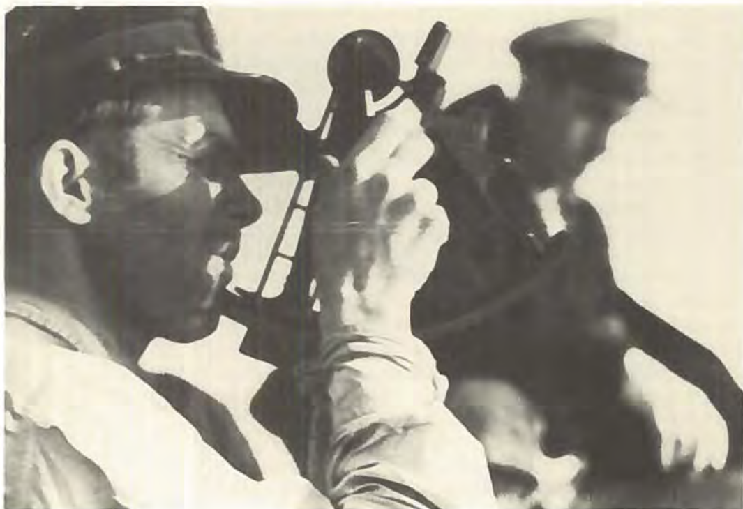
Styrmand Knafve tager solbøjen med sin sekstant, medens forfatteren styrer og passer kompasset.
