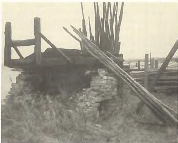
Tjæregryden i Gundestrup. Ovenpå ligger afløbsbakken med bunden i vejret.
