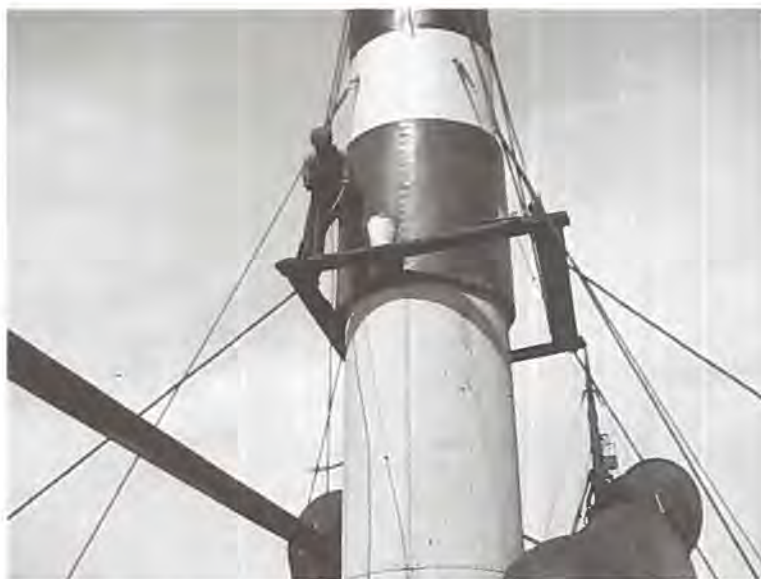
Arbejdsplatformen til skorstenen på SIS Elsborg rigget op for vedligeholdelsesarbejder. (Foto: Bernhard David Larsens samling. Handels- og Søfartsmuseet).
