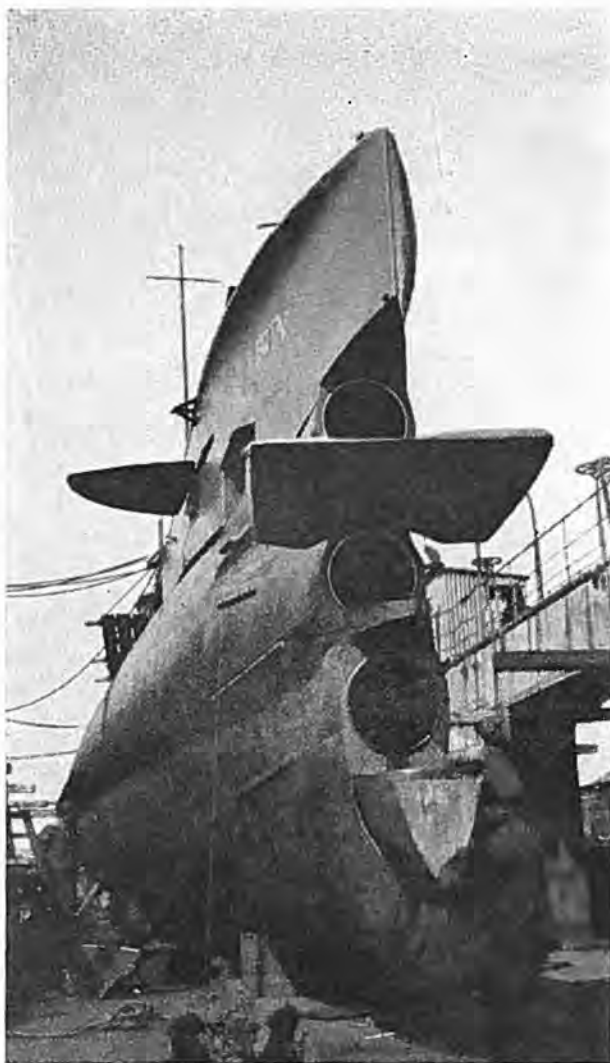
Fig. 119. Ubaaden ROTA i Flydedok. Alle tre Støvnør er aabne og Forroret (oppe paa Siden) svunget ud. 1924. (Fot. Orlogskaptajn Steensen).
