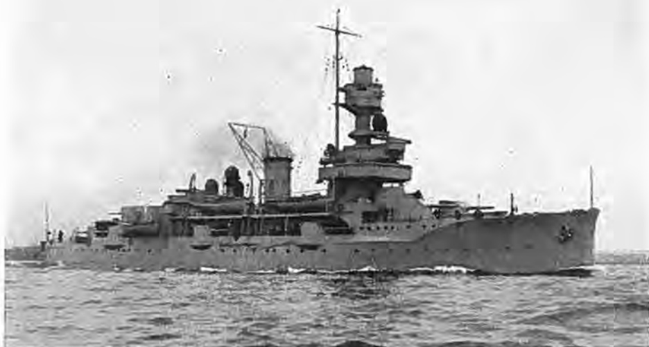
Fig. 108. NIELS JUEL i 1936 efter Ombygningen, hvor Trebensmasten blev erstattet af en Pælemast og agterste Mast af to Skorstenshorn. (Fot. Orlogskaptajn Steensen).
