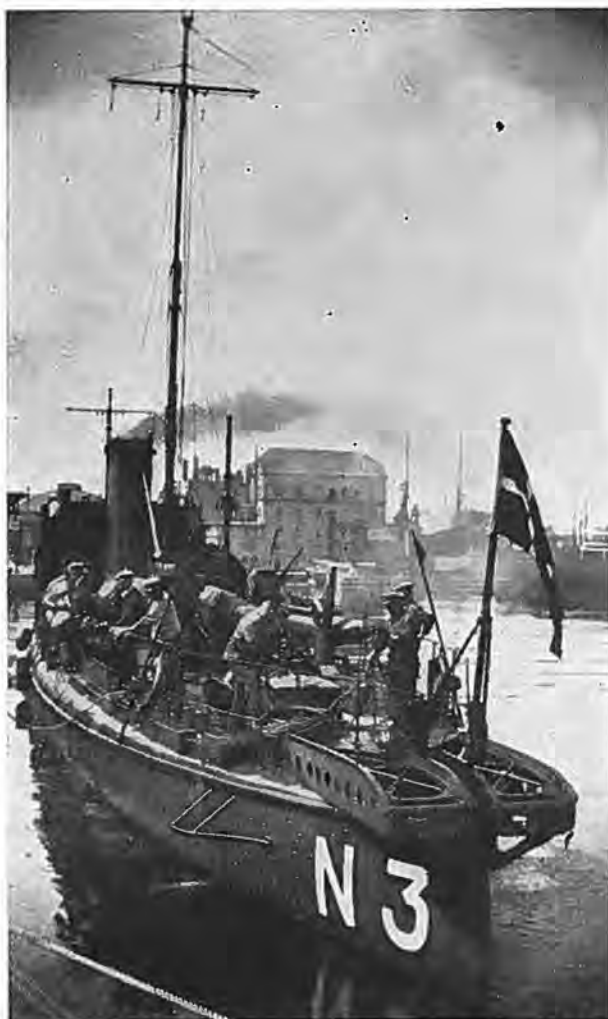
Fig. 98. Torpedobaaden SPÆKHUGGEREN med paasatte Skinnebaner til Mineudlægning, 1935. (Fot. Orlogskaptajn Steensen).
