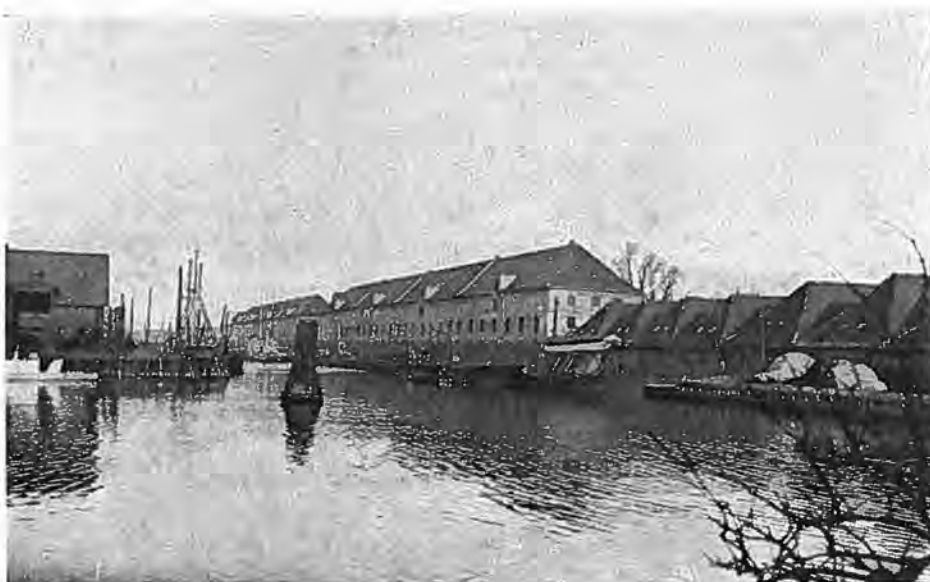
Fig. 174. Søndre Maste- og Rundholtskure samt Søndre og Nordre Magasin set fra Kristiansholm. (Fot. Bygningsvæsnet.)
