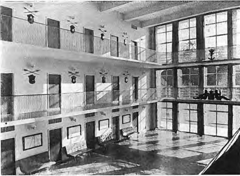
Fig. 150. Hallen i Søofficersskolen paa Holmen. (Fot. Bygningsvæsnet).
