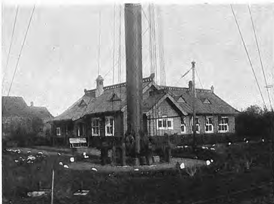
Fig. 186. Flaaderadiostationen. (Fot. Bygningsvæsnet.)
