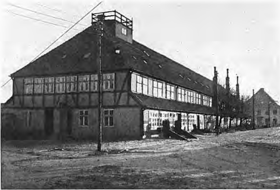
Fig. 176. Spanteloftsbygningen set fra NV. (Fot. Bygningsvæsnet.)
