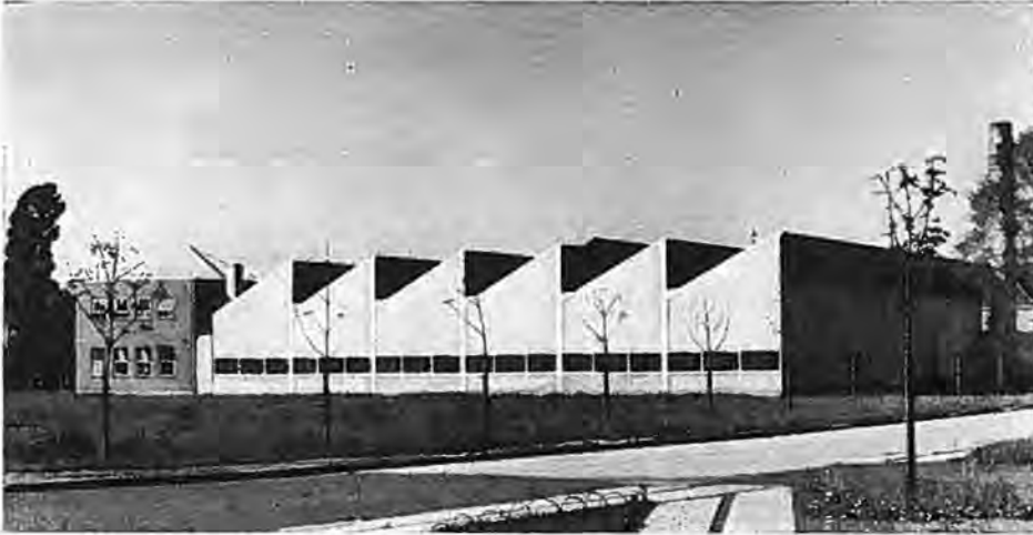
Fig. 188. Nyt Torpedoværksted. (Fot. Bygningsvæsnet.)
