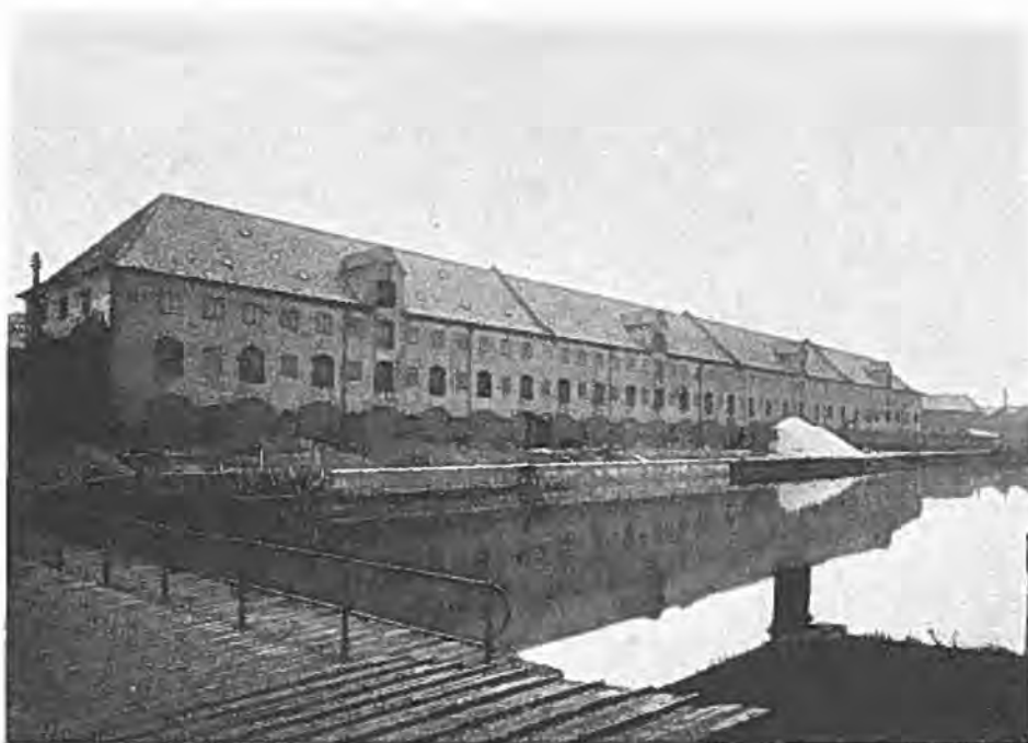
Fig. 170. Takkelloftsgraven og Søndre Magasinsbygning. (Fot. Bygningsvæsnet.)
