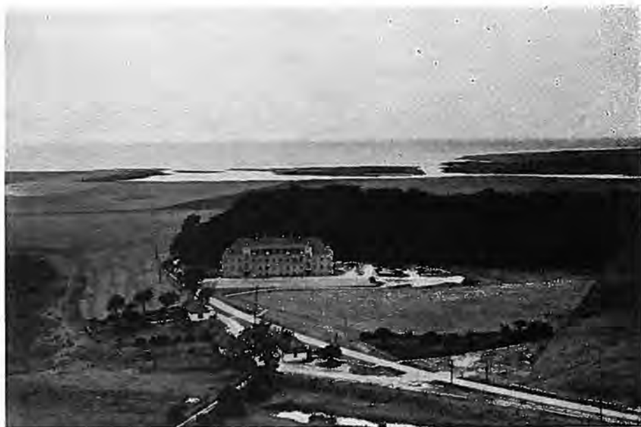
Fig. 211. Kasernen ved Luftmarinestationen Avnø. (Fot. Flyvevæsnet.)
