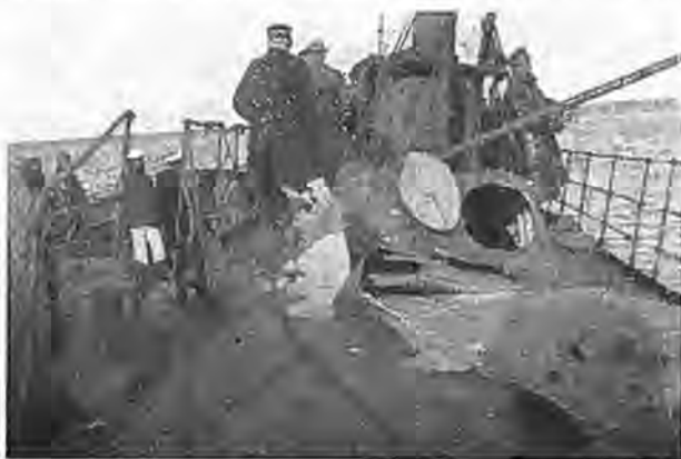
Fig. 126. Virkning af 12 cm Granat paa SØBJØRNEN's Fordæk ved Forsøgsskydning i 1929.
