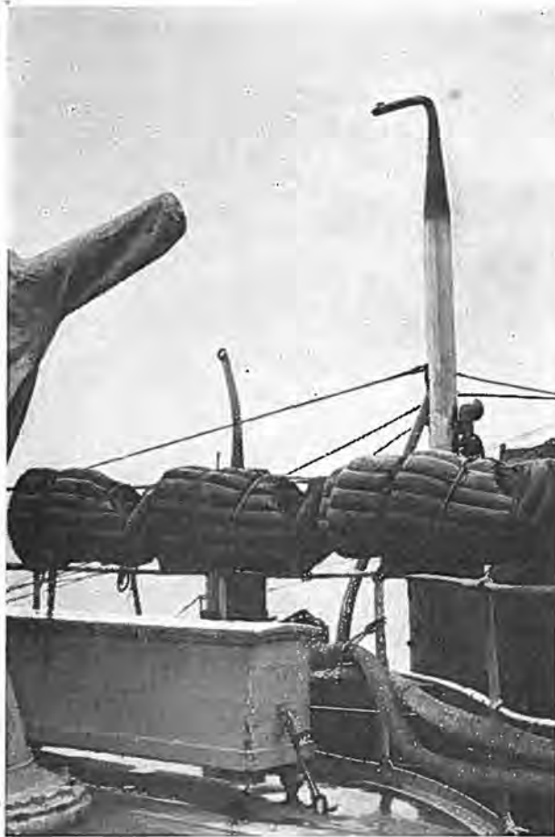
Fig. 92. Ubaaden BELLONA med begge Periskoper bøjet efter Kollision i neddykket Tilstand med en Torpedobaad fortejet paa Siden af Værkstedsskibet GRØNSUND i 1926. (Fot. Orlogskaptajn Steensen).
