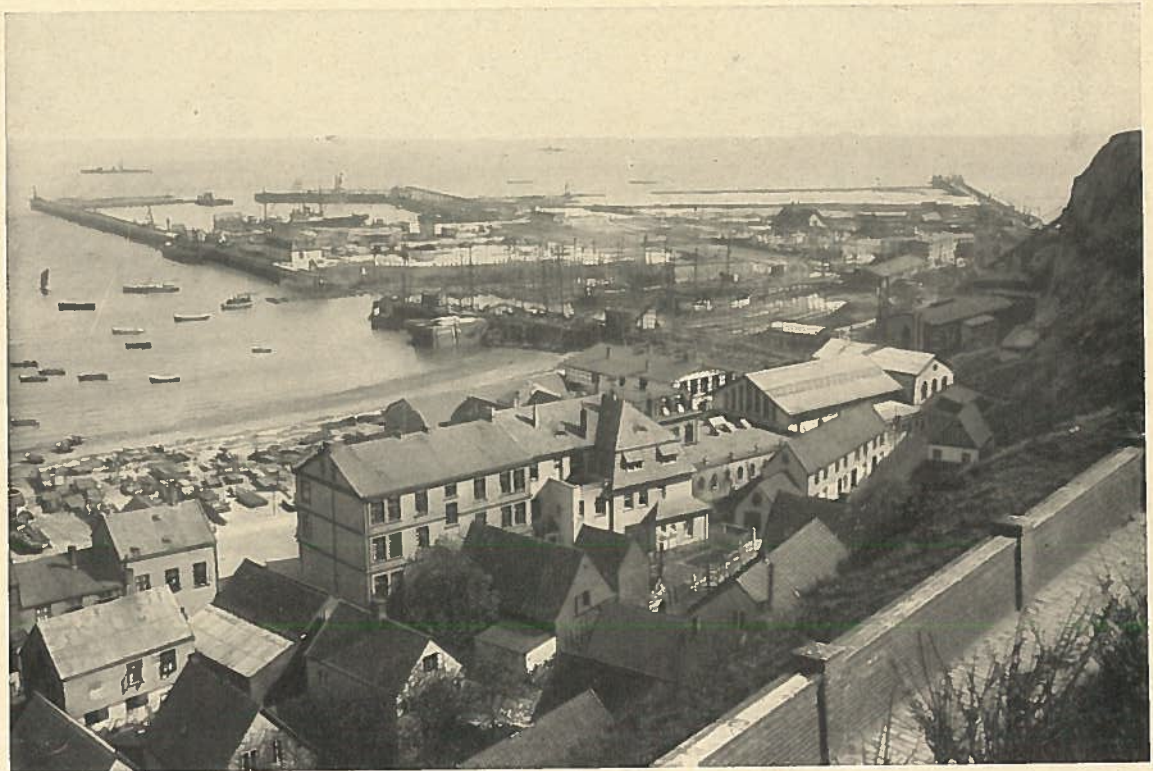
Die neuen Hafenbauten in Helgoland
