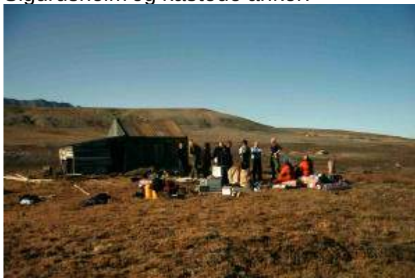
2 fupper og 7 besætningsmedlemmer fra TRITON samt Tommy holder "taktikmøde", før de går i gang med renoveringen af Sigurdsheim
