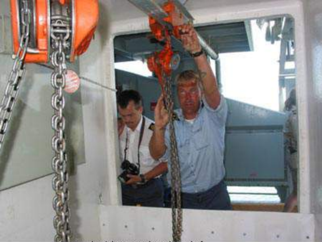
Der arbejdes med turbineløft
