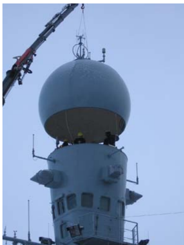
Hatten af for VÆDDEREN Radardomen måtte nedtages for at udskifte defekte radardele
