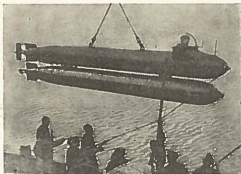
Tysk Een-Mands-Torpedo klar til Udsætning. Den øverste „Torpedo“ benyttes som en Slags Dværg-Torpedobaad. Ude i Stævnen sidder Føreren bag en Kuppel af splintfrit Glas. Foran sig har han sine Sigteapparater. Under „Torpedobaaden“ hænger selve Torpedoen, som frigøres, naar Føreren er naaet ind i Skudposition
