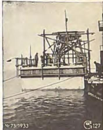
Eisenbeton-Senkastengründung in Gleitbauweise
